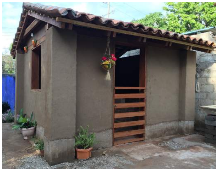
8. Cocina edificada con la técnica de Bajareque Cerén en Ixtepec, Oaxaca por Cooperación Comunitaria.
