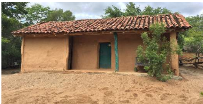
7. Casa de bajareque en Ixtepec, Oaxaca, sin ningún daño después de los terremotos del 2017
